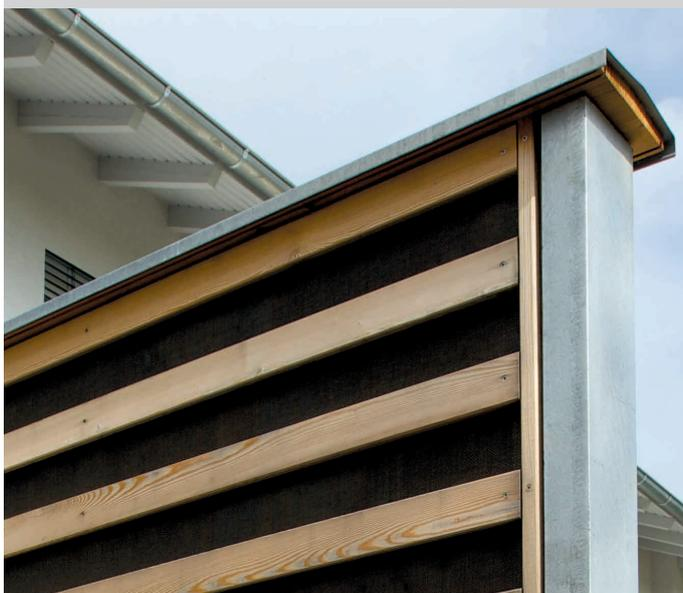
Ausführung mit Stahlpfosten
