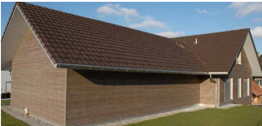
Sibirische Lärche, Rhombusprofil, sägerau, endbehandelt mit Silverwood, 26 x 65 mm
