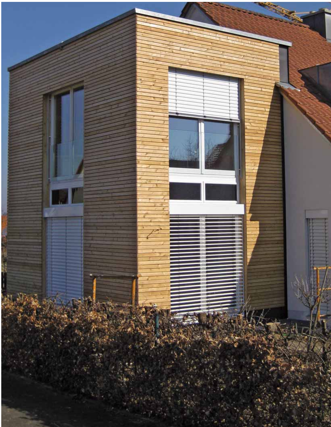
Sibirische Lärche, Rhombusprofil, gehobelt, 26 x 65 mm
