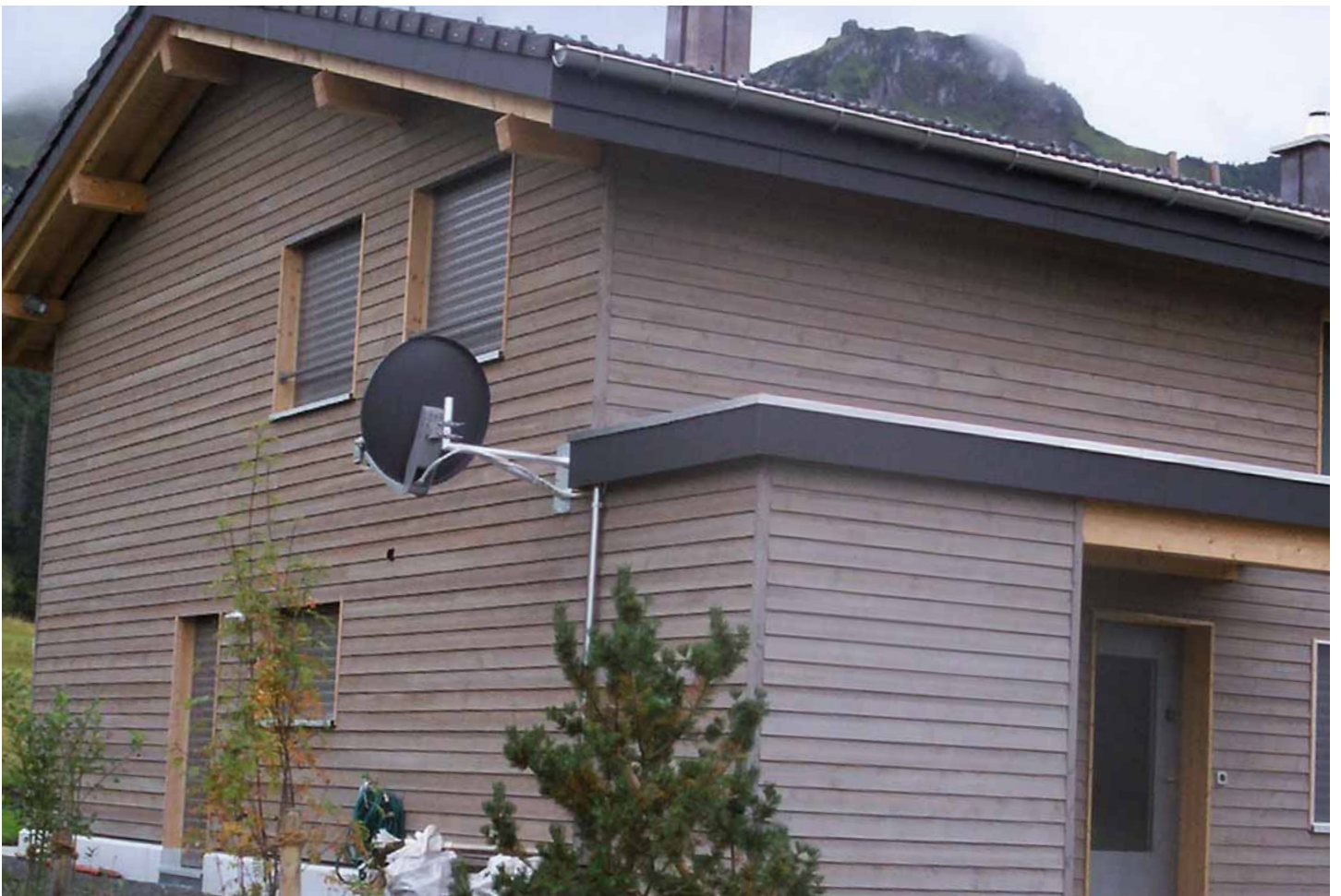
Douglasie, Fassadenprofil, endbehandelt mit Pullex Silverwood
