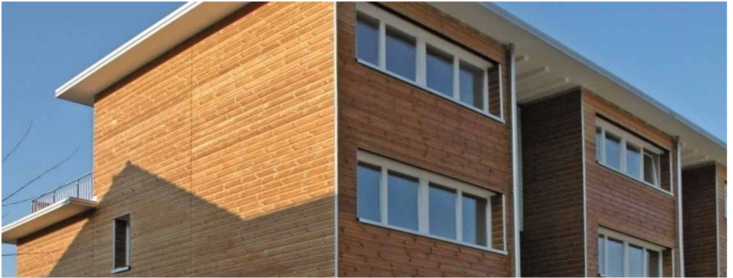
Thermoholz Kiefer, Stulpschalung, 19 x 142 mm
