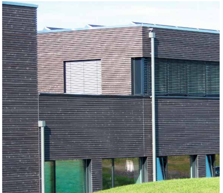
Sibirische Lärche, Rhombusleisten, behandelt mit Silverwood Graualuminium
