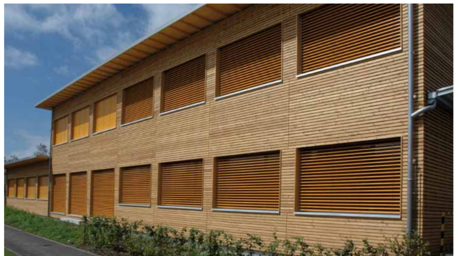
Sibirische Lärche, Rhombusleisten, behandelt mit Protector Plus
