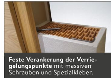
**Feste Verankerung der Verriegelungspunkte** mit massiven Schrauben und Spezialkleber.
