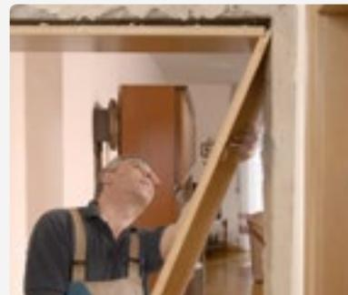
Die Tapete wird um die Bekleidung herum sauber eingeschnitten. Mit einem Stecheisen wird die Zierbekleidung von der Zarge gedrückt und das Futterbrett der Zarge im unteren Drittel mit einem sauberen Schnitt durchgesägt. Danach lässt sich die Zarge problemlos ausbauen. Bei der gesamten Demontage fällt kein nennenswerter Schmutz an, da keine Stemmarbeiten oder Ähnliches erforderlich sind.
